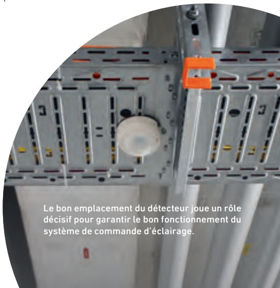
Fig. 1: Un détecteur PIR s'active beaucoup plus tôt lorsqu'une personne passe sur le côté que lorsqu'elle se dirige directement dessus.
